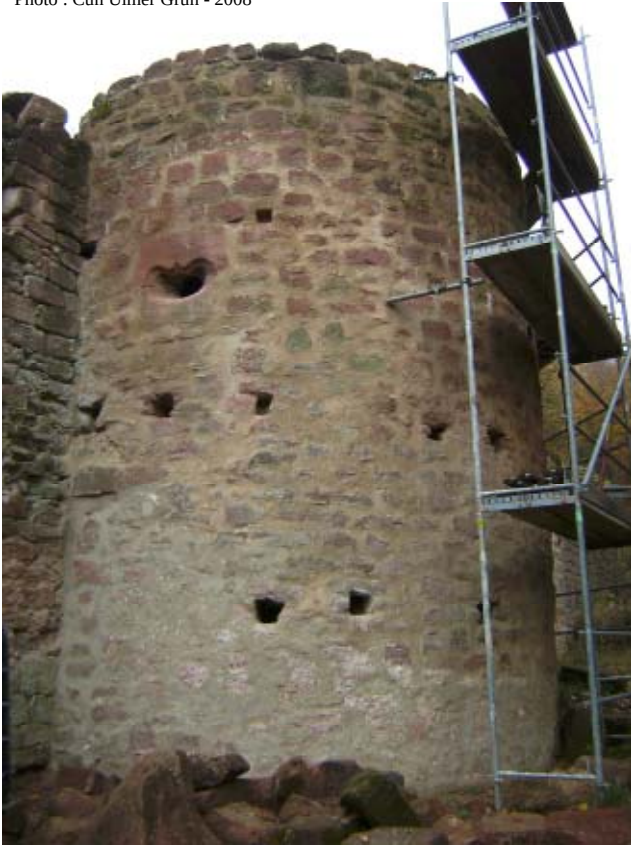
Tour semi-circulaire côté sud
