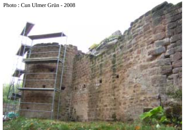
Ci-dessus – Tour semi-circulaire de flanquement est et son mur d'enceinte adjacent en secteur 8
