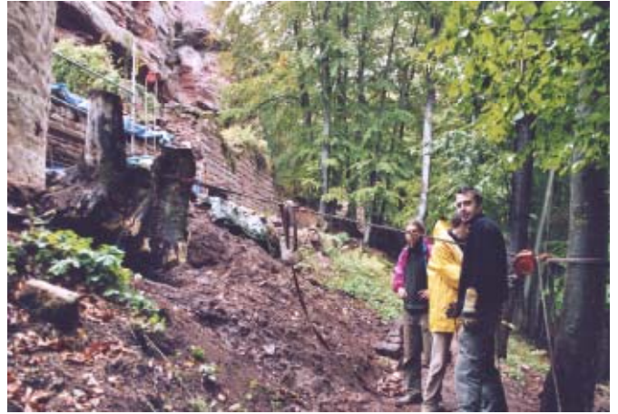
Ci-dessus : 2004 – Rempart est, secteur 8. Dégagement d'une souche devant la tour semi-circulaire.
