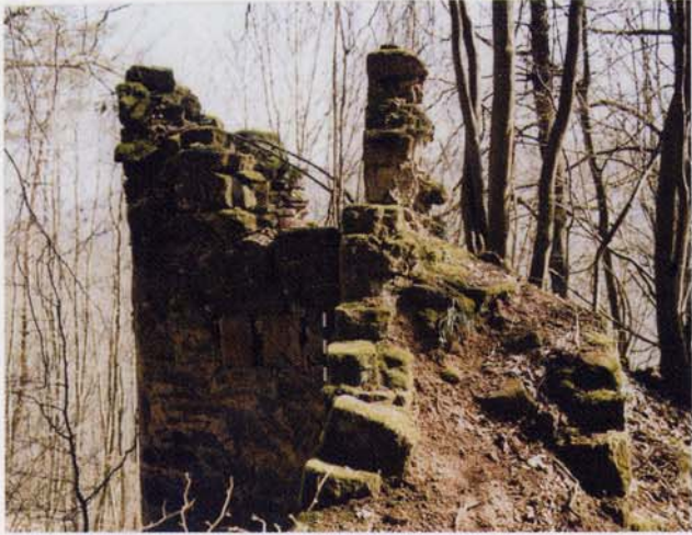
Schoeneck - Tour de flanquement Nord-Est, état avant travaux (Photo M. Heissler)
